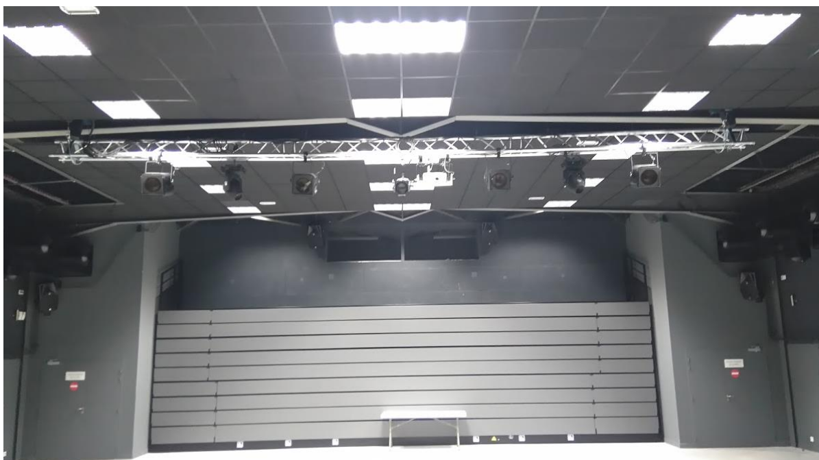
Poutre de face
